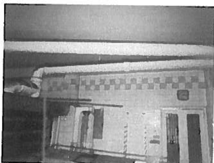
Conduit de fluide Amiante ciment
